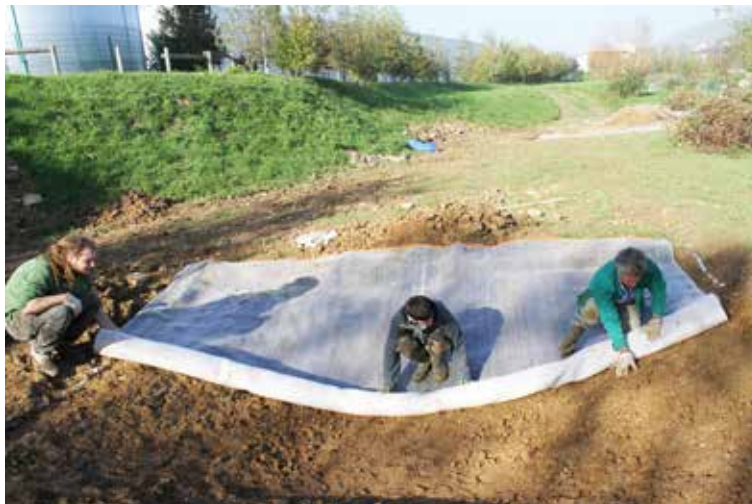
Déroulé de membrane à argiles bentonitiques à Malzéville... censées être plus naturelles, elles n'ont jamais réellement bien fonctionné.
